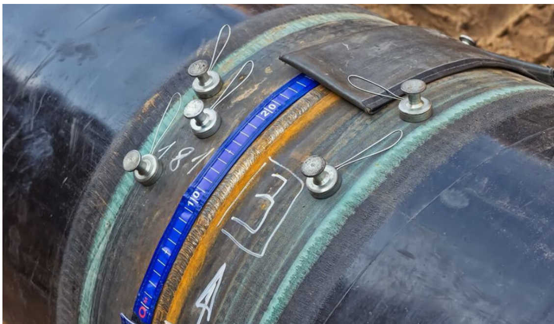
Foto 7.1.5/A - Controlli non distruttivi sulle saldature
