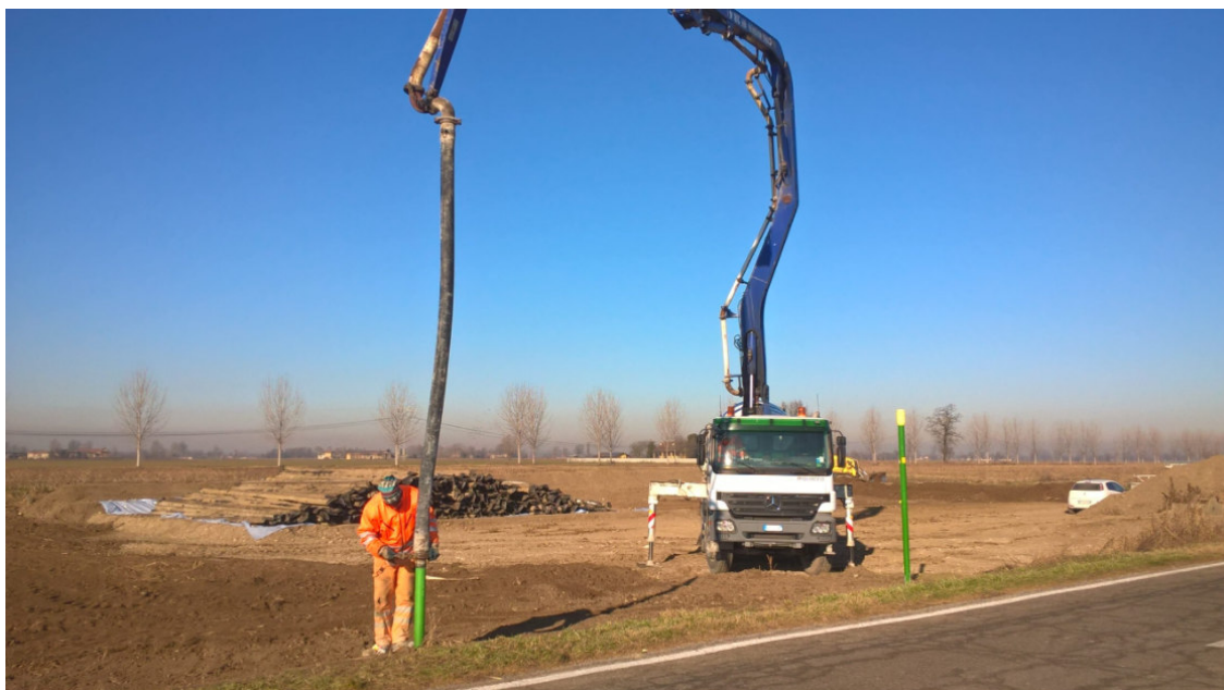
Foto 7.2.7/A – Inertizzazione del tubo di protezione
