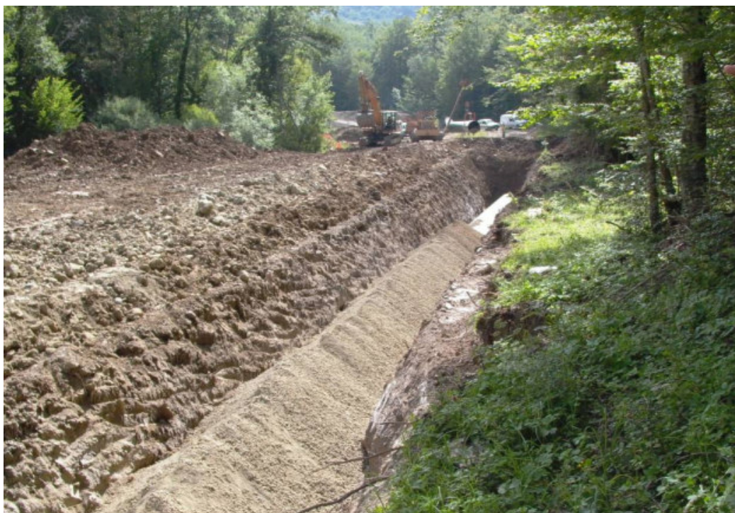
Foto 7.1.9/A – Pre-rinterro della condotta
