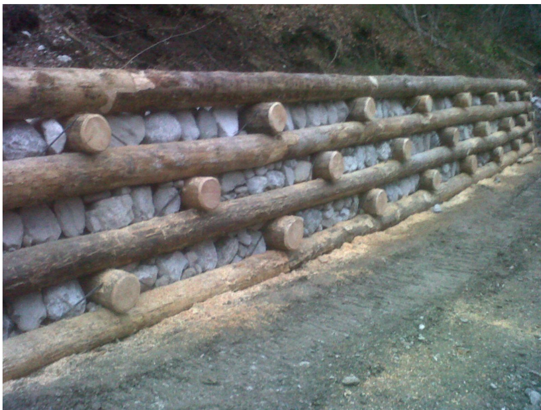
Foto 9.1.1/F - Ricostituzione spondale con muro cellulare in legname e pietrame
