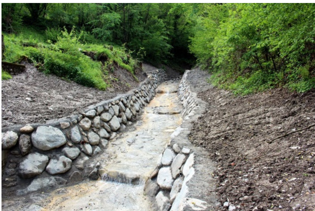
Foto 9.1.1/G – Regimazione di piccoli corsi d'acqua con cunetta in massi
