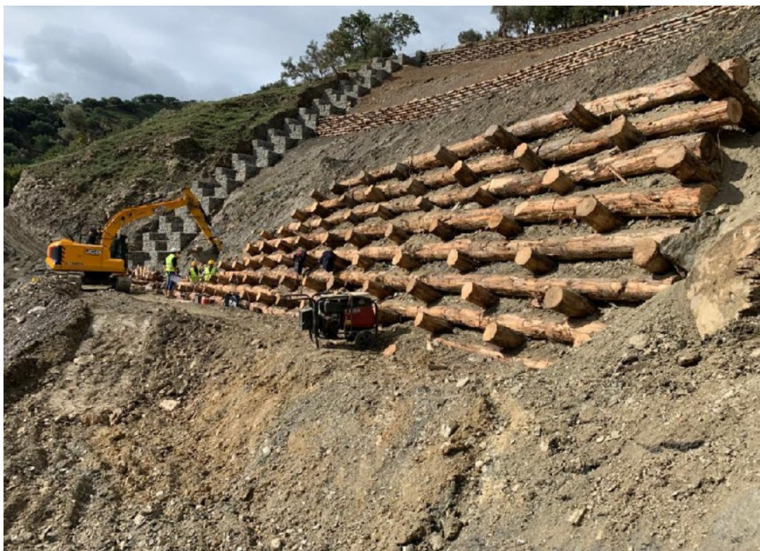
Foto 9.1.1/B – Muro cellulare in legname a doppia parete
