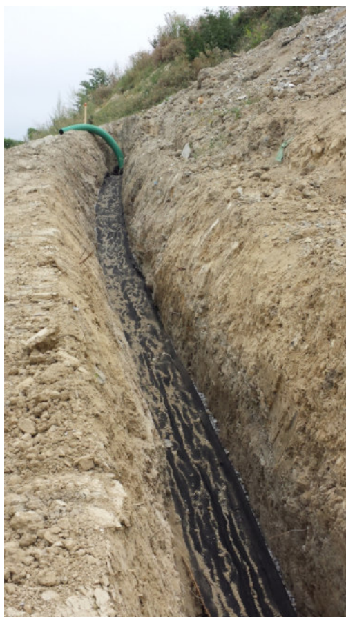
Foto 9.1.1/M – Trincea drenante sotto condotta
