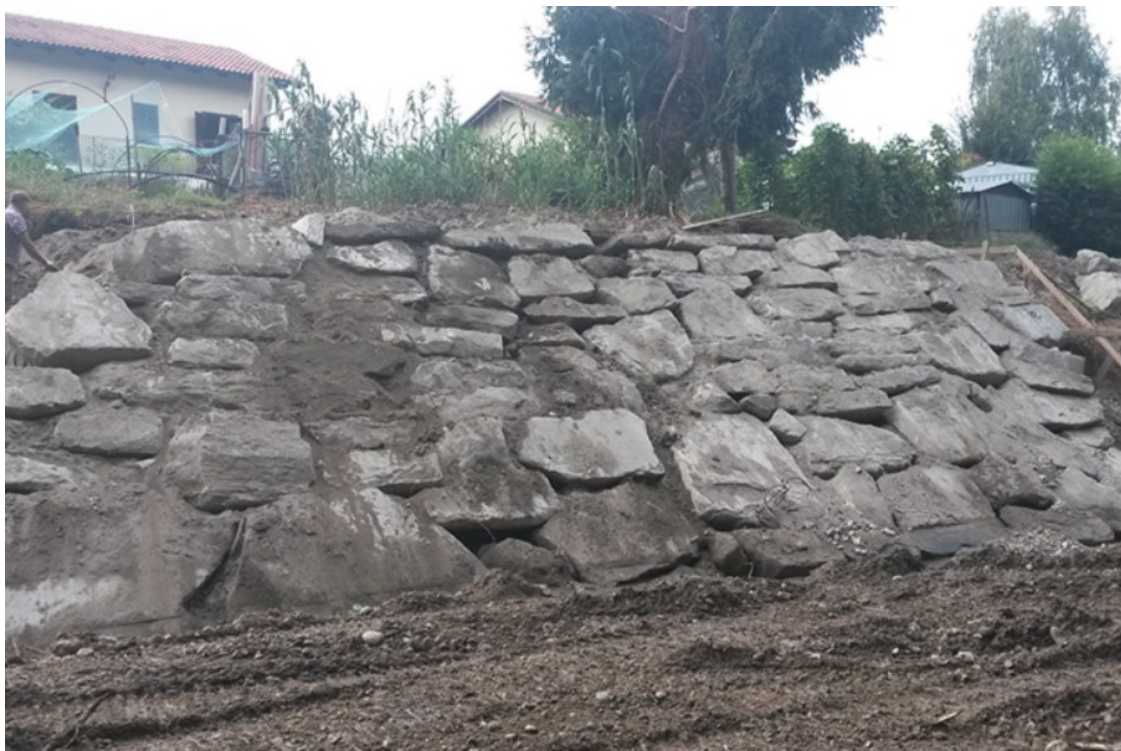
Foto 9.1.1/H – Rivestimento spondale in massi
