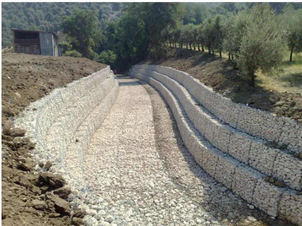
Foto 9.1.1/I – Ricostruzione dell'alveo con gabbioni e materassi metallici
