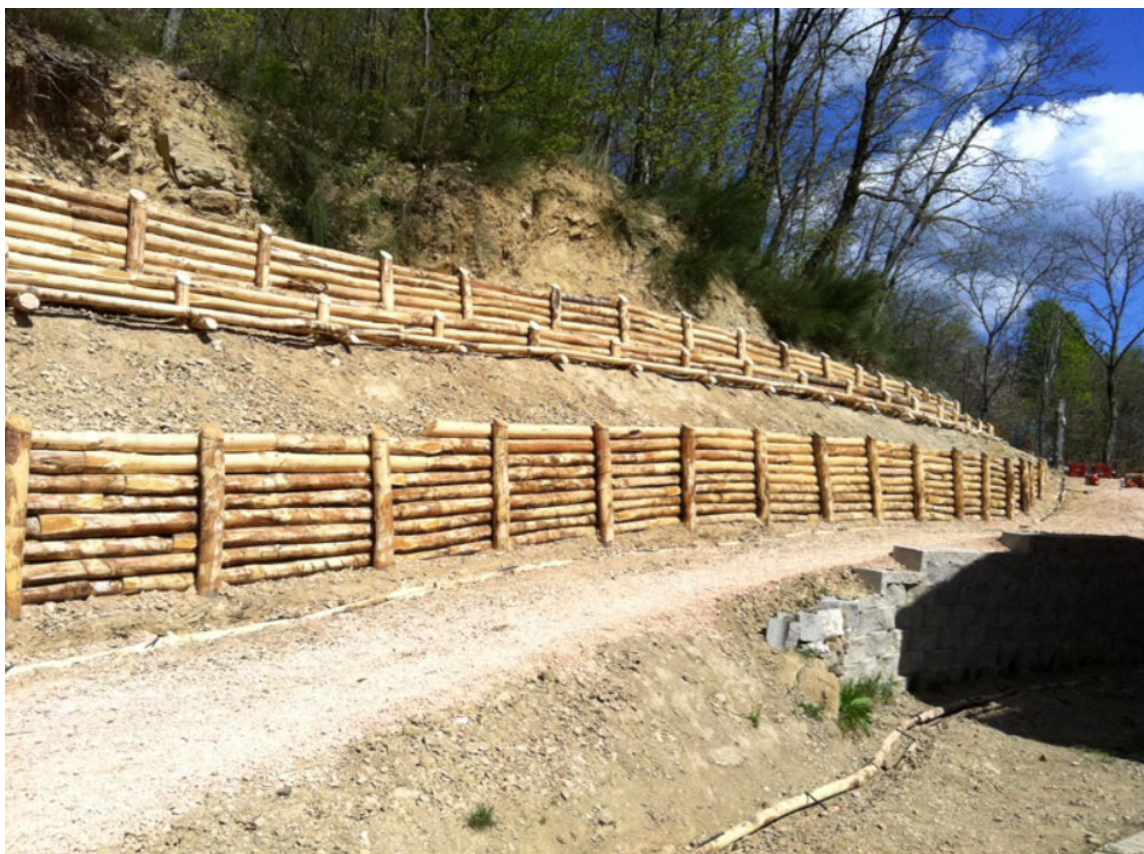
Foto 9.1.1/A – Palizzate di contenimento in legname
