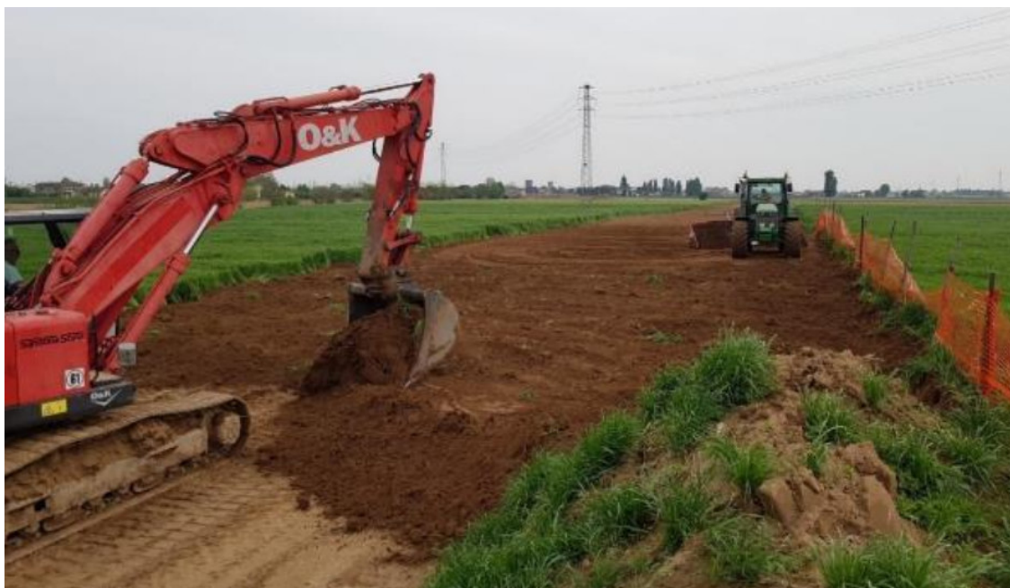
Foto 7.1.9/C - Distribuzione dello strato humico superficiale
