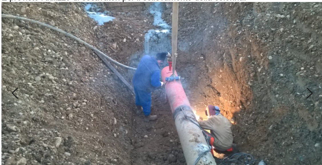
Foto 7.2.4/A – Sezionamento condotta
