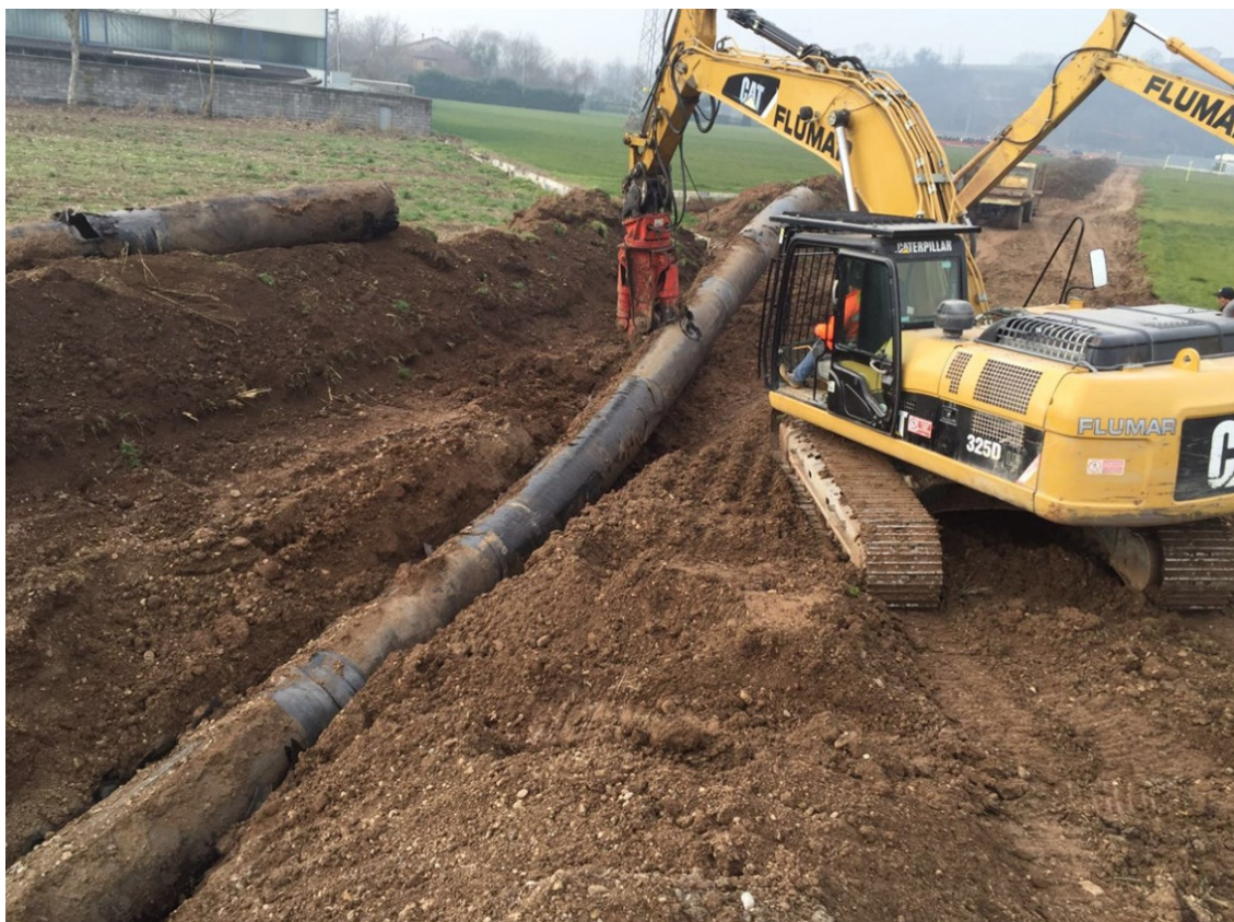
Foto 7.2.5/A - Sollevamento tubazione sezionata da rimuovere
