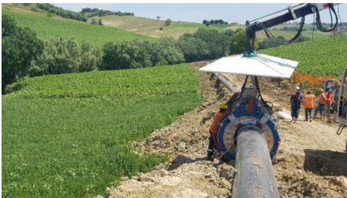
Foto 7.1.4/B - Saldatura automatica
