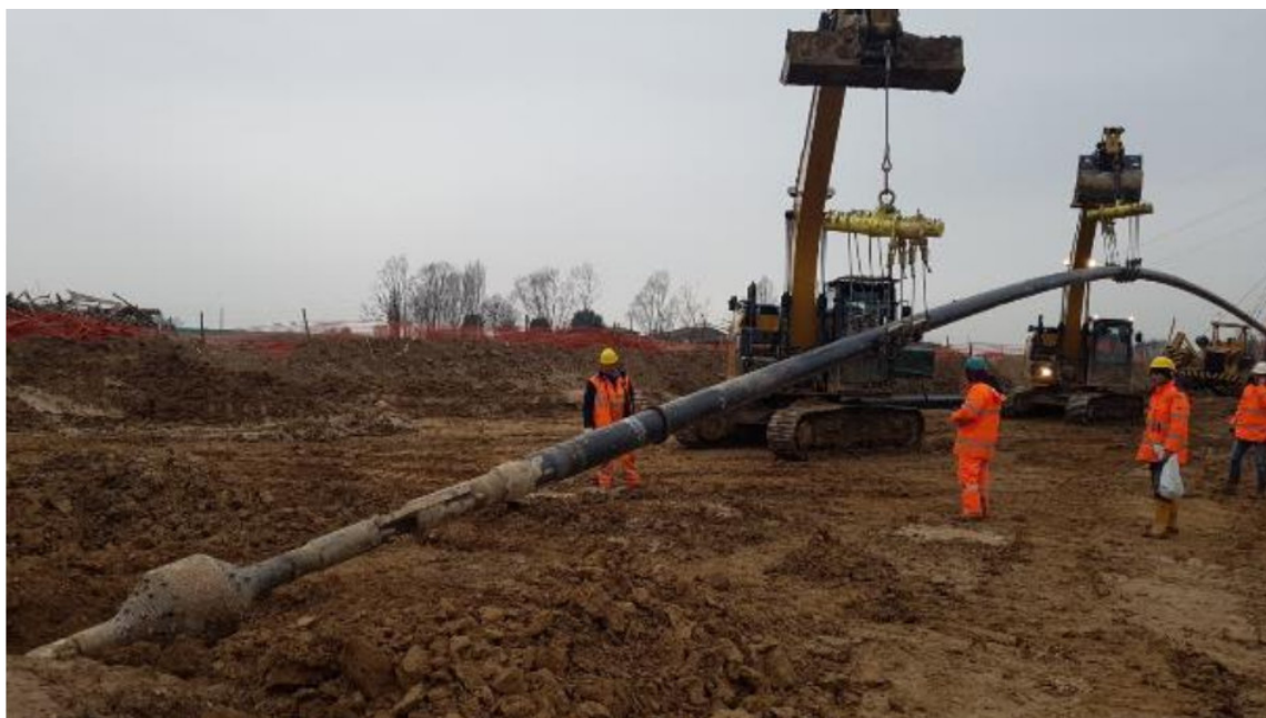
Foto 7.1.11/B - Operazione di varo della TOC
