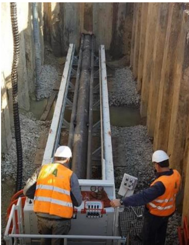
Foto 7.1.10/A - Trivellazione con spingitubo
