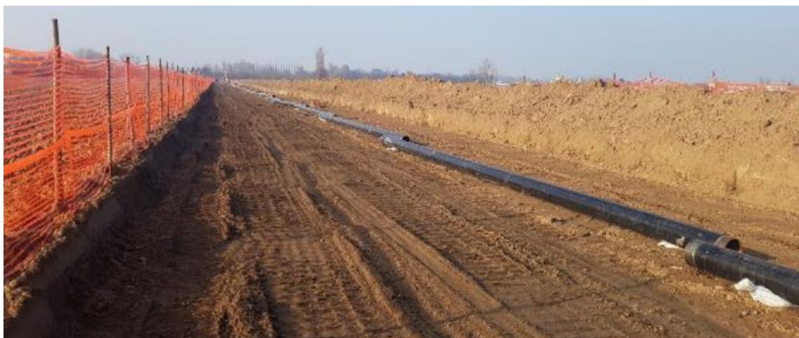
Foto 7.1.3/A – Sfilamento delle tubazioni di linea
