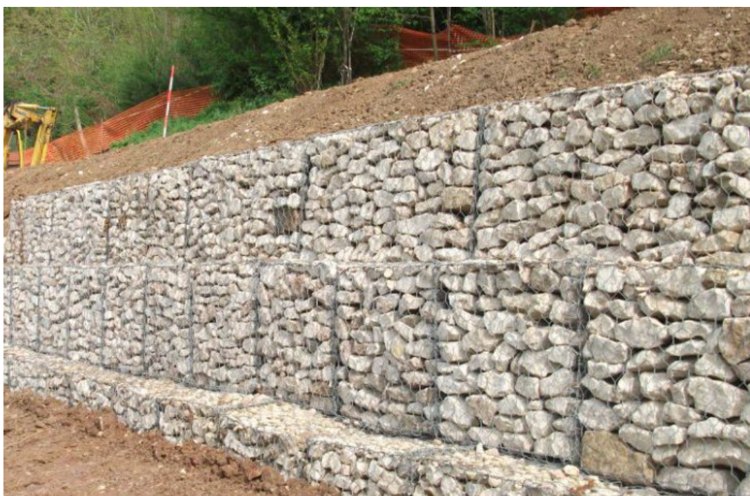
Foto 9.1.1/C – Muro gradonato in gabbioni
